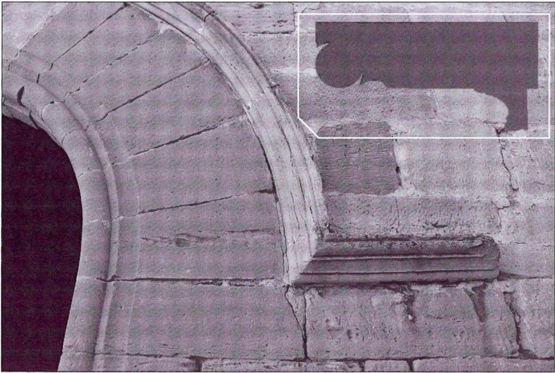
FIGURA 5: DETALL I SECCIÓ DE LES MOTLLURES EXISTENTS A LA PORTA D'ENTRADA AL TEMPLE
