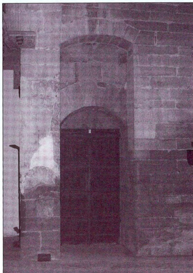
FIGURA 14: L'INTERIOR DE LA PORTETA AMB EL RESPECTUÓS AFEGITÓ FET EN LA REFORMA GÒTICA
